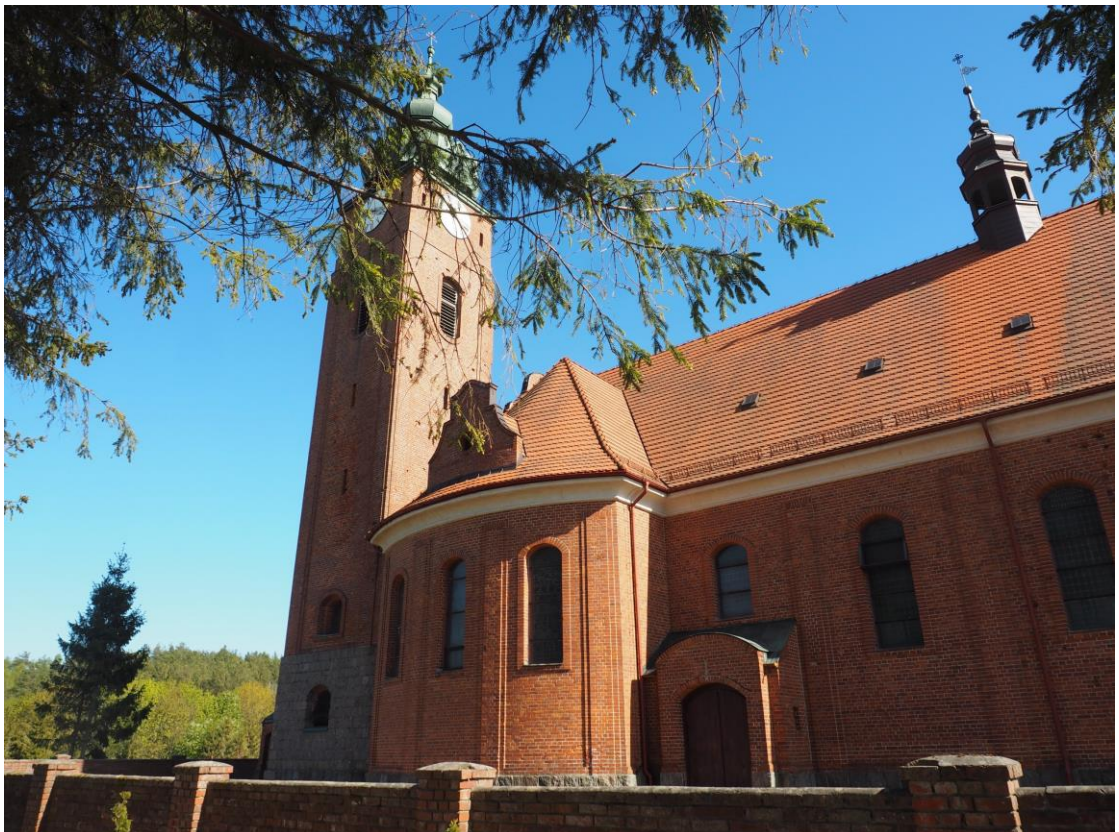
Fot. 5. Wygodza łączyńska, kościół PW. Św. Józefa. Północna elewacja korpusu, transeptu i wieży.
