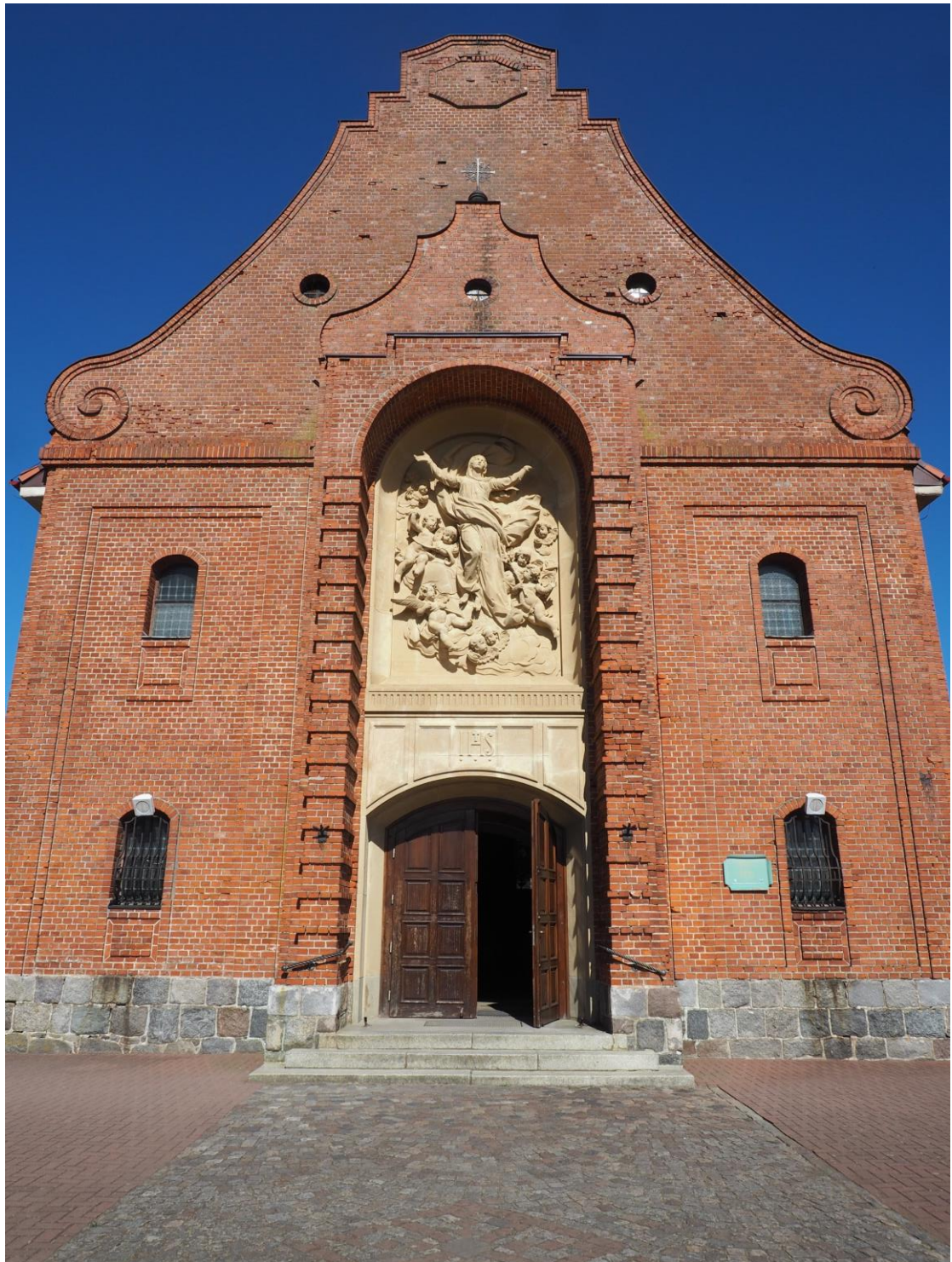
Fot. 3. Wygoda Łączyńska, kościół PW. Św. Józefa. Elewacja zachodnia – fasada.
