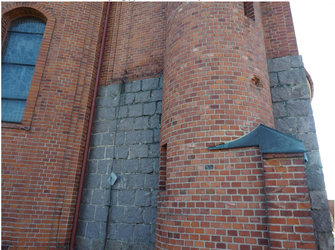
Fot. 24. Wygoda Łączyńska, kościół PW. Św. Józefa. Północno wschodni narożnik wieży. Widoczna wieżyczka schodowa.
