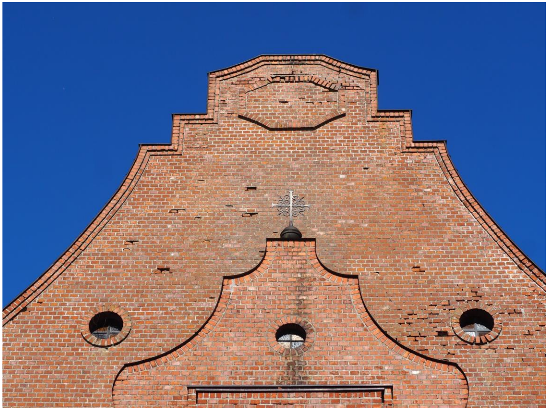
Fot. 17. Wygoda Łączyńska, kościół PW. Św. Józefa. Elewacja zachodnia – fasada. Szczyt.
